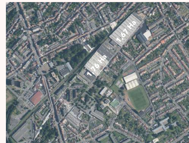
Site industriel ECL, au coeur de Ronchin
